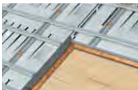
Isolamento per copertura a falda inclinata con struttura in legno
