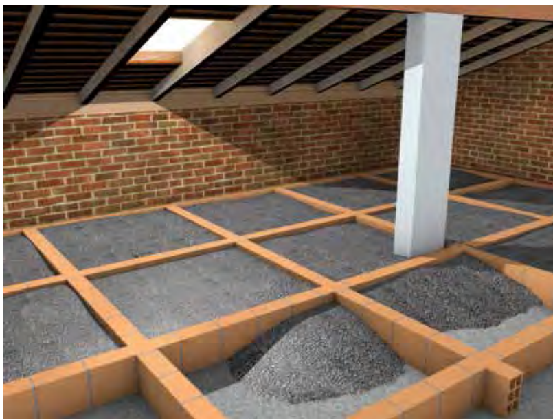
Isolamento del sottotetto mediante insufflaggio
