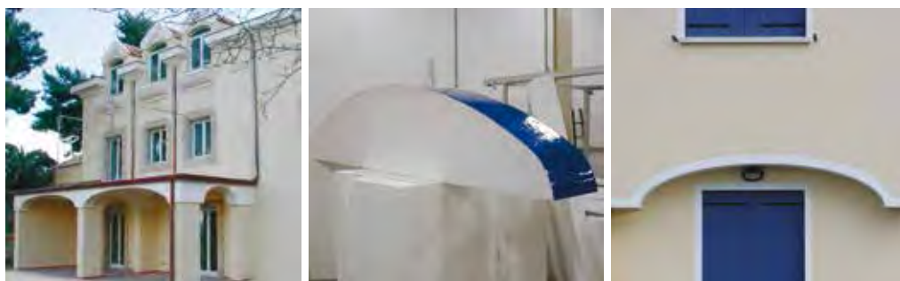
Casseforme per getti di architravi curvilinee in calcestruzzo
