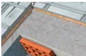
Isolamento per copertura a falda inclinata con struttura in latero-cemento
