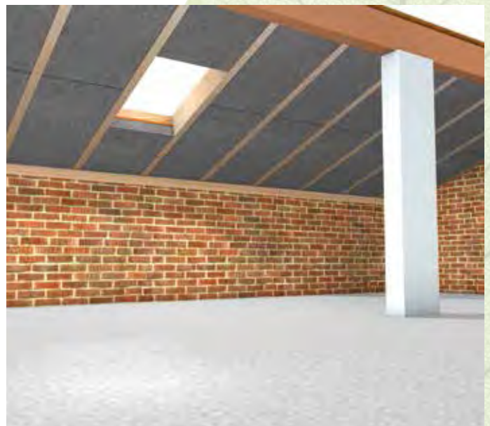
Isolamento del sottotetto con travi a vista
