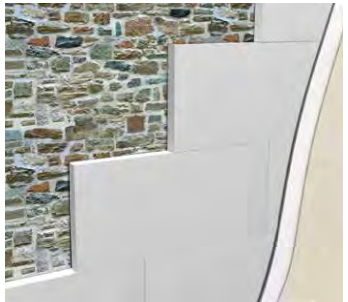
Isolamento a cappotto su parete in pietra
