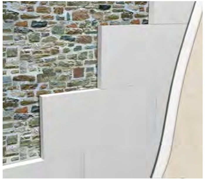
Isolamento a cappotto su parete in pietra
